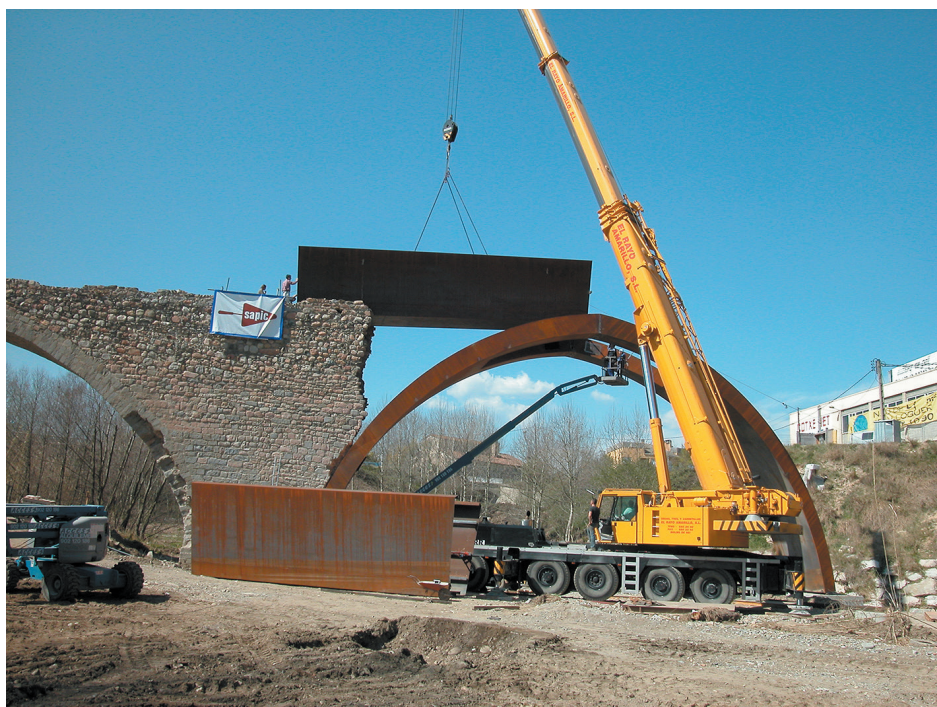
Muntatge de la biga d'acer patinable sobre el nou arc. (Foto Quim Reberté, 2000).
