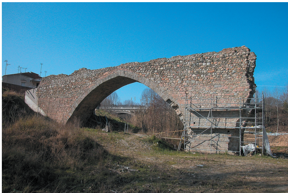
Reconstrucció de la pila central del pont Trencat. (Foto Quim Reberté, 2000).
