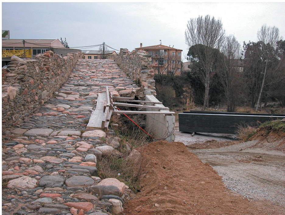
Reconstrucció del costat Palautordera del pont Trencat. (Foto Quim Reberté, 2000).
