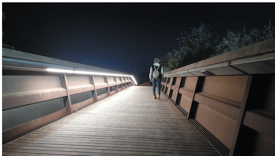
Il·luminació nocturna del pont Trencat, anant cap al costat Palautordera. (Foto O. Farrerons, novembre 2023).
